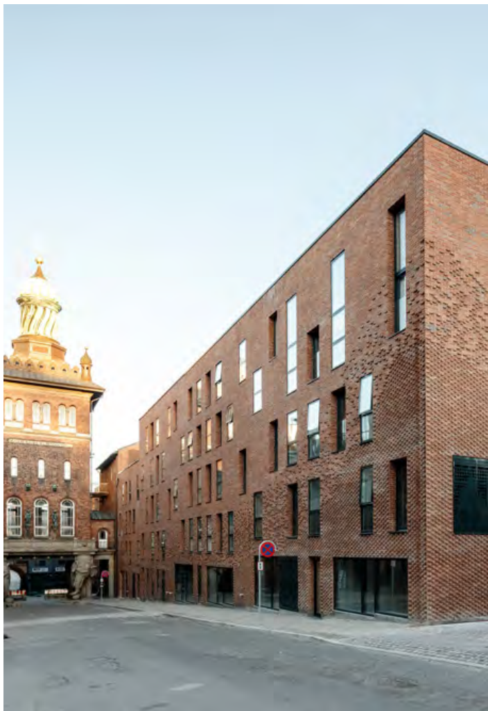
Abb. 110: Ansicht des Neubaus am historischen Stadttor, Quelle: Rasmus Hjortshøj
