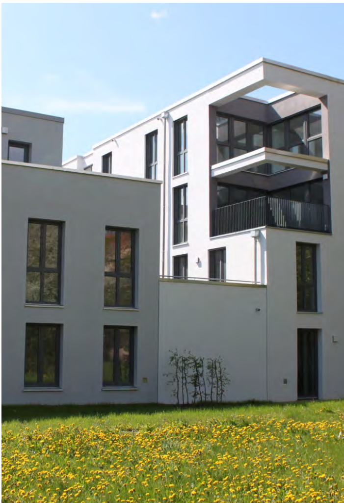
Abb. 75: Gebäudeansicht im Innenhof, Quelle: Märkplan GmbH
