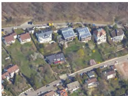
Abb. 5: Potenziale auf bebauten Flächen: große Grundstücke mit zweiseitiger Erschließung
