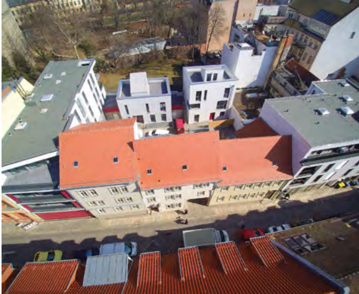
Abb. 74: Baulückenschluss und Nachverdichtung im Innenhof, Quelle: Silvio Kelz
