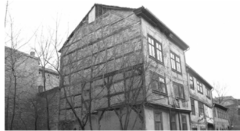
Abb. 76: Bestandsgebäude vor der Sanierung, Quelle: Märkplan GmbH
