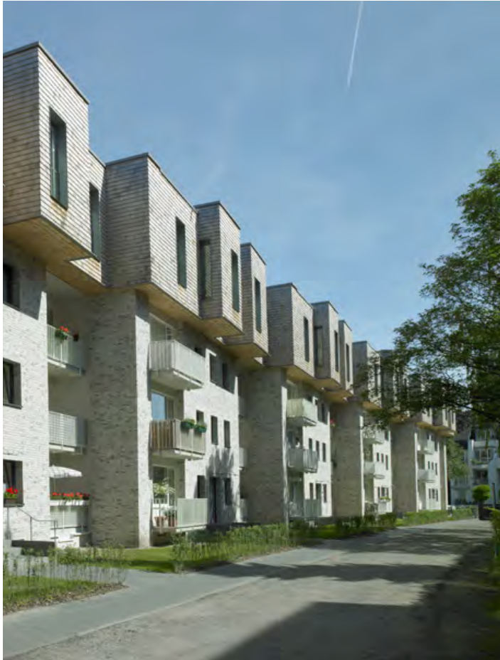
Abb. 81: Aufstockung der Zeilenbauten, Quelle: Martin Lukas Kim
