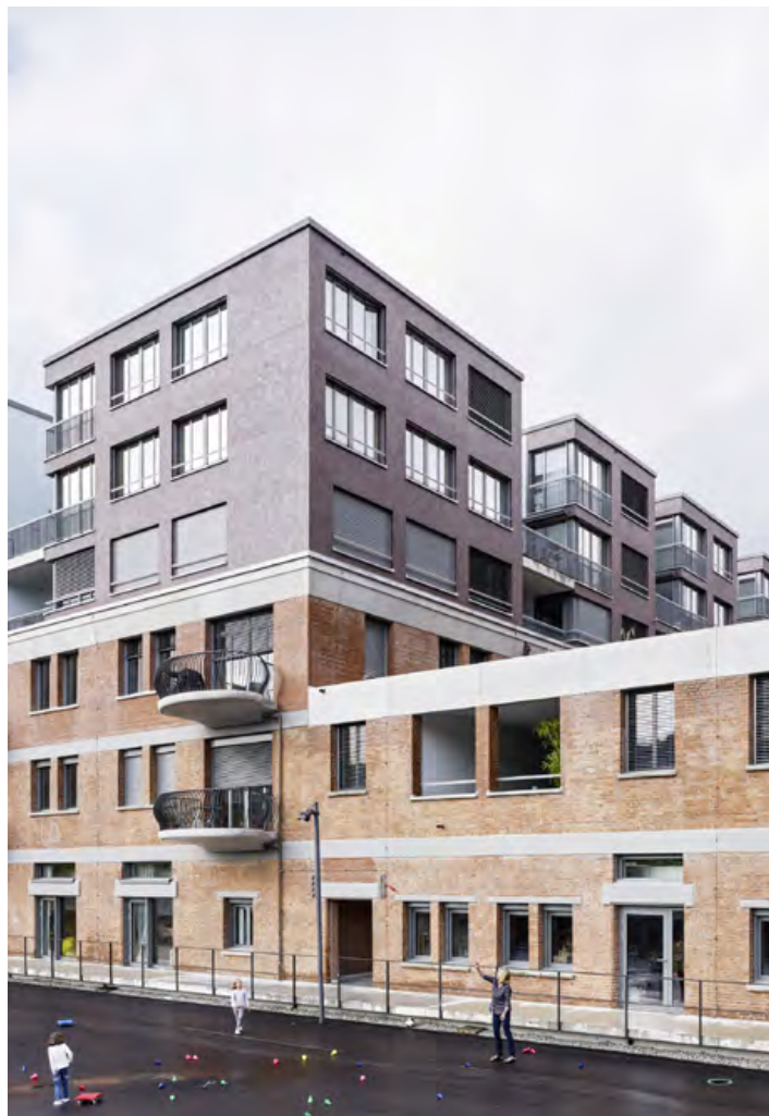
Abb. 84: Aufstockung der ehemaligen Lagerhalle, Quelle: Georg Aerni
