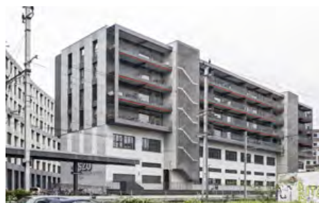
Abb. 115: Ehemaliges Bahnhofsgebäude nach der Aufstockung, Quelle: Georg Aerni
